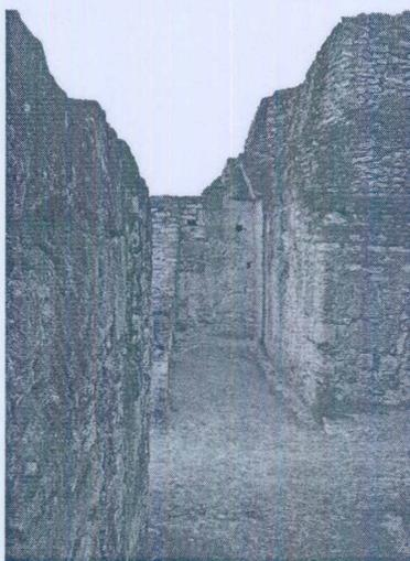
*Foto 3. Grieta presente en el muro Norte de la cámara Oeste del Edificio 216 previo a su atención correspondiente*
